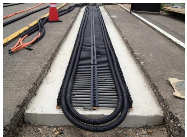
Figura 2: Instalação dos cabos sob o asfalto – (Disponível em NOVATE.RU , 2013)
