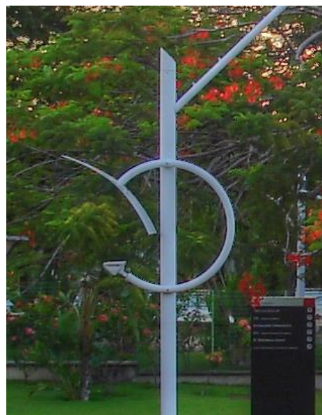
Figura 2. Lâmpada de vapor de metal, usada nas áreas externas dos Ciclos Básicos I e II.
