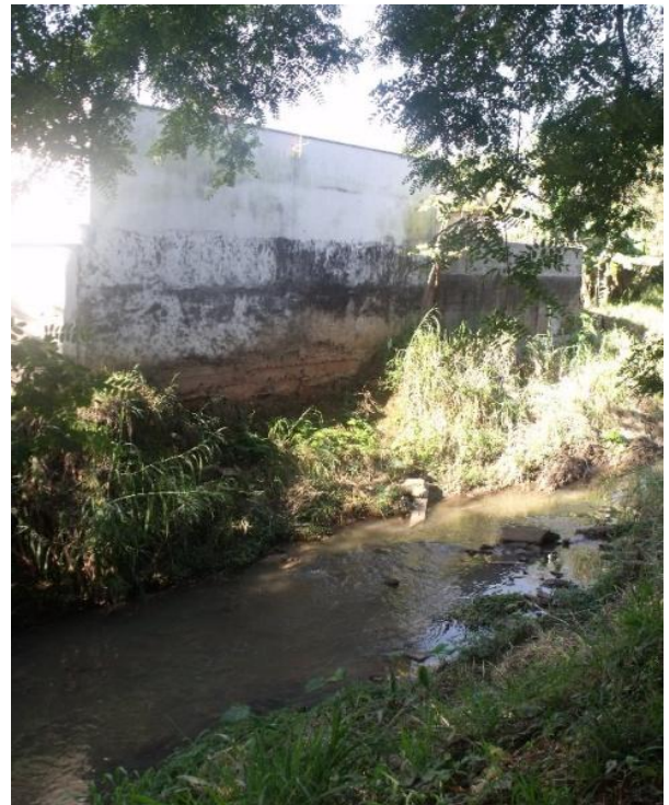
Figura 7 - Situação atual da margem do rio, com as construções irregulares.
