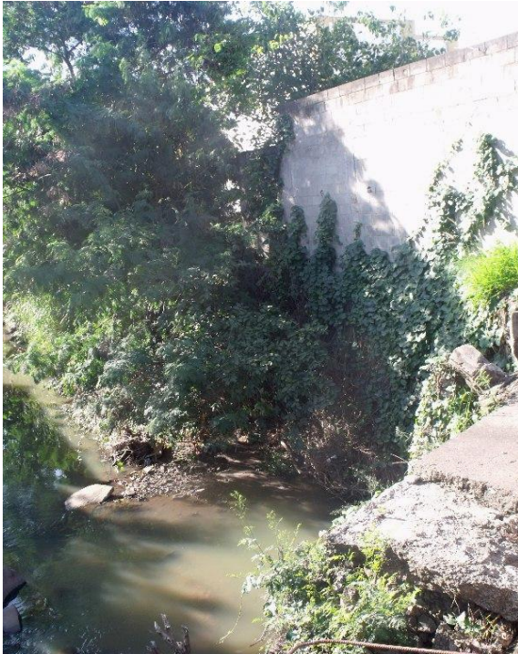
Figura 5 - Situação atual da margem do rio, com as construções irregulares.
