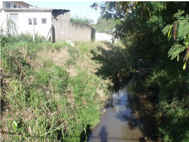
Figura 6 - Situação atual da margem do rio, com as construções irregulares.
