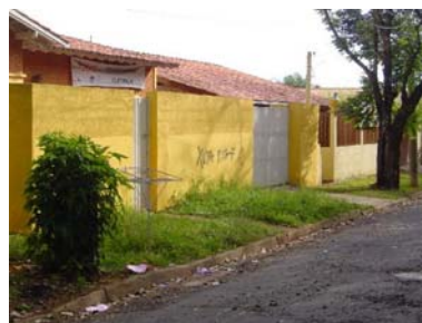
Figura 3. Calçada de cimento na saída da garagem.
