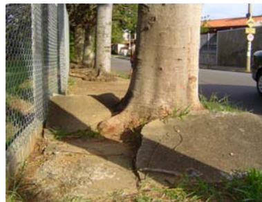
Figura 2. Raízes de árvores quebrando a calçada.
